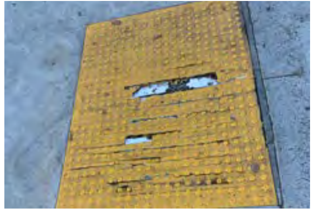
Izquierda: Una marca peatonal está descolorida en la carretera Misión al Norte y calle 1ra al Este. Derecha: Las cúpulas truncadas amarillas en la esquina sureste de la Plaza del Sol al Este y carretera Misión al Norte, al lado de la Escuela Preparatoria Méndez están agrietadas.
