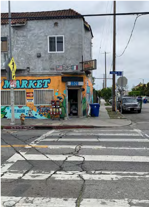
Izquierda y derecha: marcas de cruce de peatones agrietadas y descoloridas a lo largo de la calle Avenida Hooper
