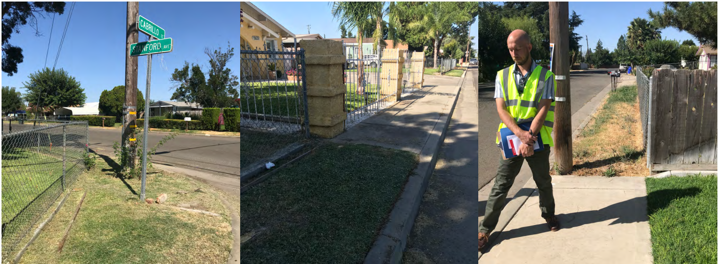
Izquierda: No hay banquetas o rampas en la esquina o en la Calle Cabrillo y la Avenida Stanford. Centro: Banquetas discontinuas a lo largo de la Avenida Stanford. Derecha: Las banquetas discontinúas en la Calle Carson crean desafíos de navegación para todos.
