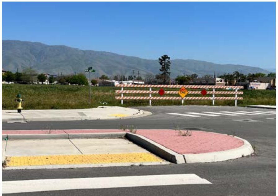
ARRIBA: La Calle Walnut Norte tiene un carril de bicicletas con rayas y protegido y una isla de refugio peatonal.
