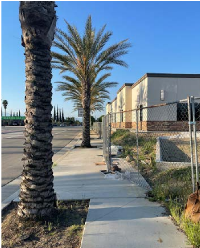
ARRIBA: Las palmeras a lo largo de la Calle Walnut Norte y la construcción actual reducen significativamente la anchura de las banquetas, dificultan y obstruyen el caminar por las banquetas para los peatones y especialmente para las personas con movilidad limitada.
