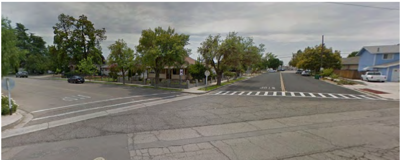
La Avenida Adams Oeste/Calle Stockton Este/Calle 6 Norte tiene alguna infraestructura pero faltan rampas que causan dificultades para algunos peatones.
