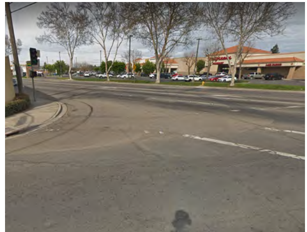
Marcas de fricción de neumáticos hechas por conductores que circulan al noreste en Paradise Road y giran a alta velocidad en la Avenida Sutter.
