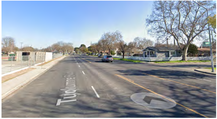
No hay señales o indicadores a los conductores de que peatones podrían estar cruzando en la intersección de la Avenida Colorado y el Bulevar Tuolumne.
