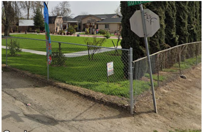
Caminos de tierra en lugar de aceras en la intersección de la Avenida Sutter y la Calle Elsie.
