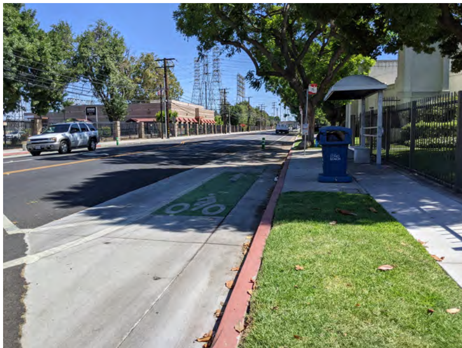
Los carriles para bicicletas protegidos frente a una parada de autobús protegida al sur de la intersección de la Calle 70 /Avenida Orange.
